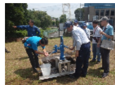
防災設備の作動確認
